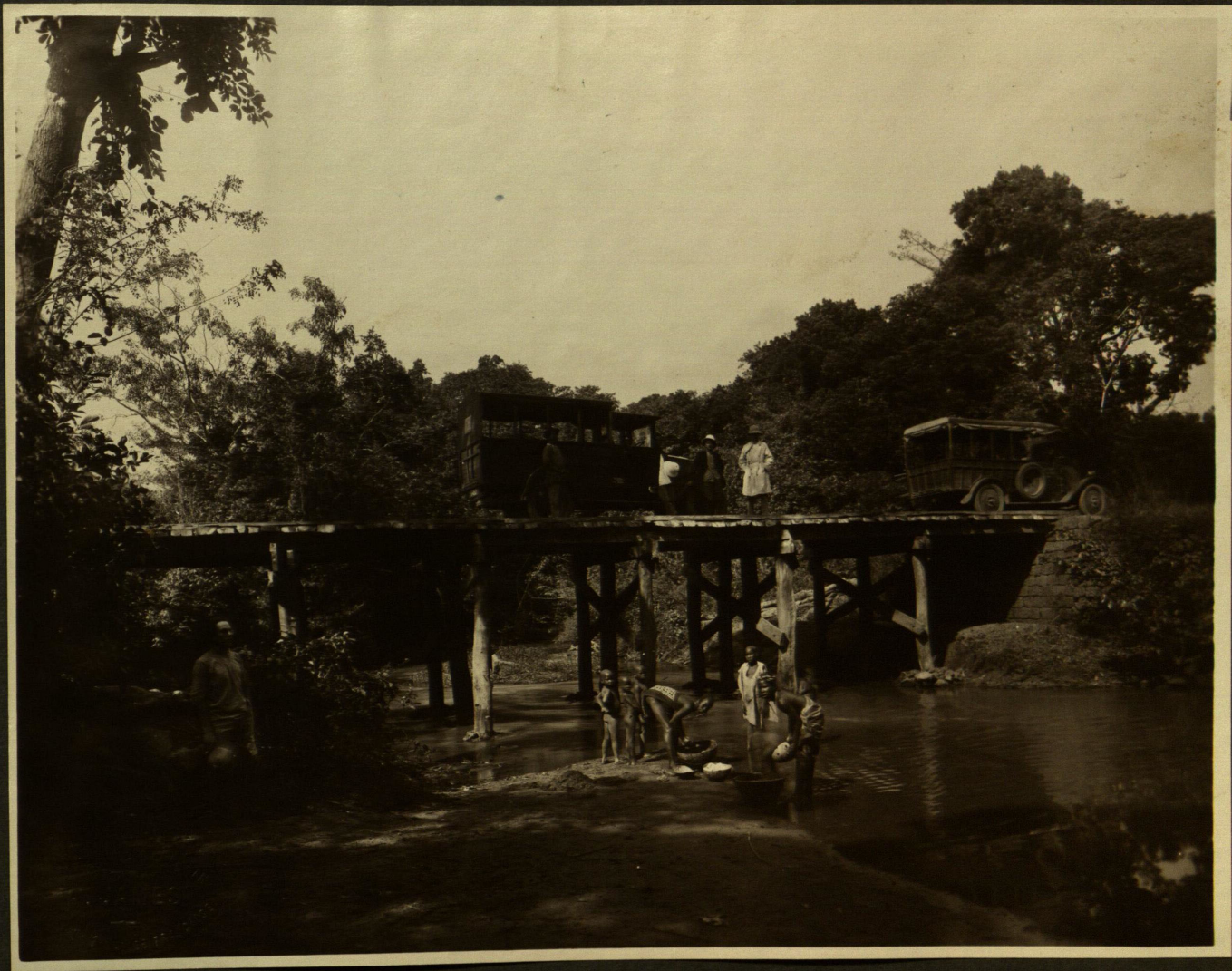
Route Hankou - Boute - Pont de 25 m. d'augetaire sur la Niassa Km. 83.
